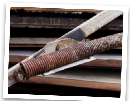
Gamla fjädrar kan sprätta av. Fjäderfästen kan lossna ur karmen. Man kan klämma fingrar på oskyddade fjädrar.
